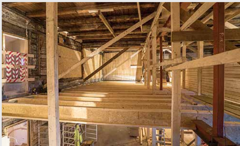
Innvendig ble det meste av det gamle revet inn til tømmerveggene. (Foto: TotalRenovering)
