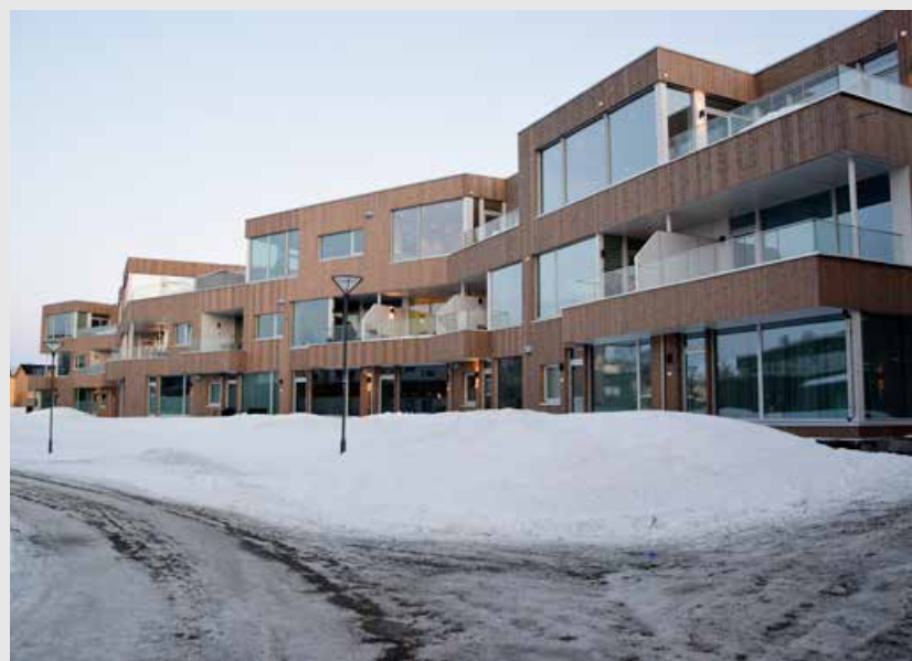
Ca 50 leiligheter er bygd i lavblokkene. Alle er solgt. Under blokkene er det garasjekjeller med plass til vel 200 biler.
